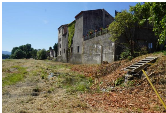
Photo n° 18 - Contournement de la Minoterie pour le dévoiement de la ViaRhôna sur les berges du Rhône à Baix
