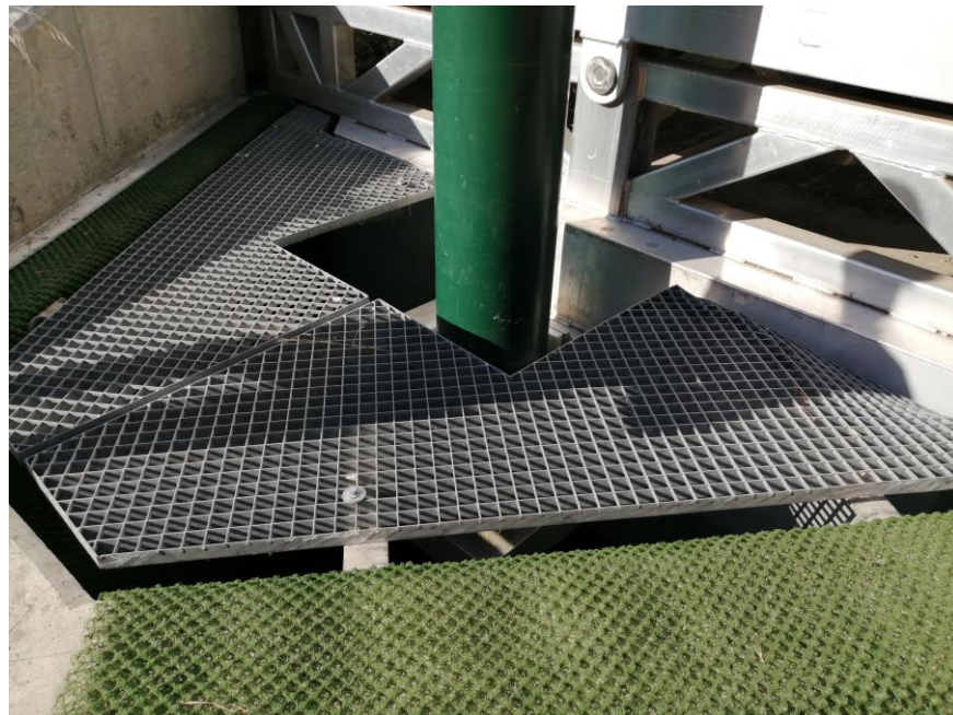
Mise en place d'un géotextile à aspérités
